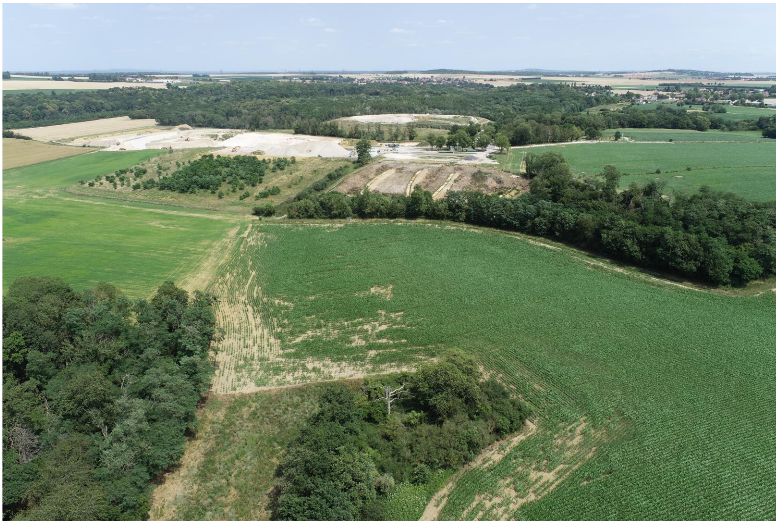
Vue aérienne de l'exploitation actuelle depuis l'Ouest (03 juillet 2023).
